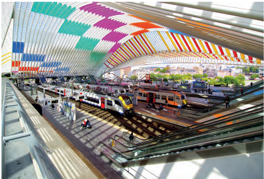
Der Bahnhof Lüttich-Guillemins besitzt eines der spektakulärsten Dächer in Europa.
